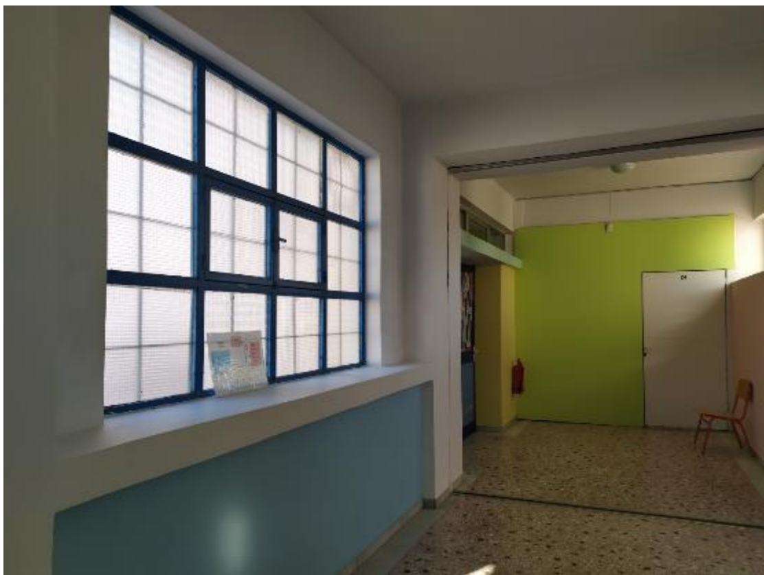
ΣΧΟΛΙΚΟ ΣΥΓΚΡΟΤΗΜΑ (Αντικατάσταση των κουφωμάτων)
