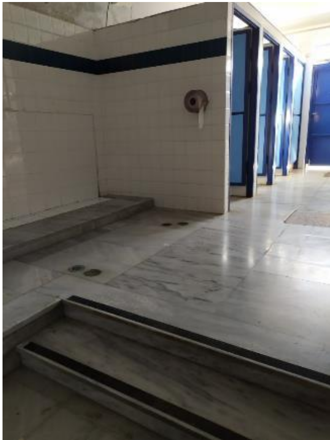
ΣΧΟΛΙΚΟ ΣΥΓΚΡΟΤΗΜΑ (Αντικατάσταση των κουφωμάτων)
