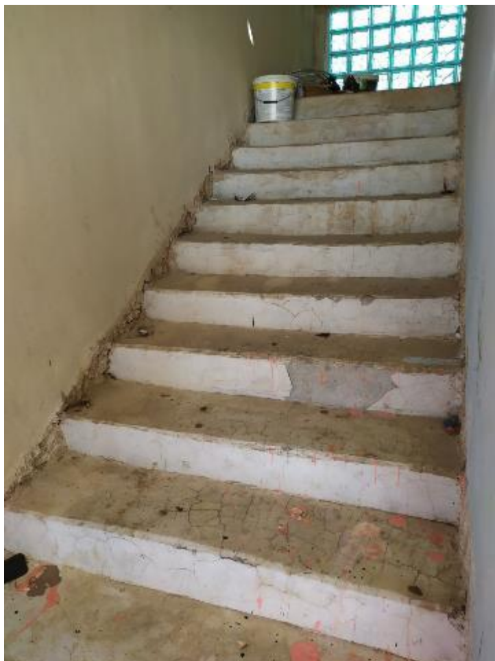
ΤΟΥΑΛΕΤΕΣ Στάθμης Υπογείου (ανακατασκευή)
