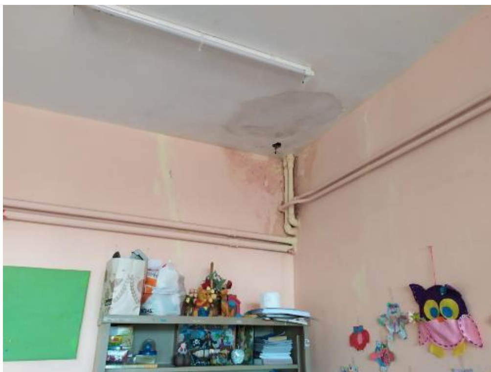
ΔΙΑΡΟΗ ΣΩΛΗΝΩΣΕΩΝ ΚΑΛΟΡΙΦΕΡ από Α' οροφο (τμηματική αντικατάσταση)
