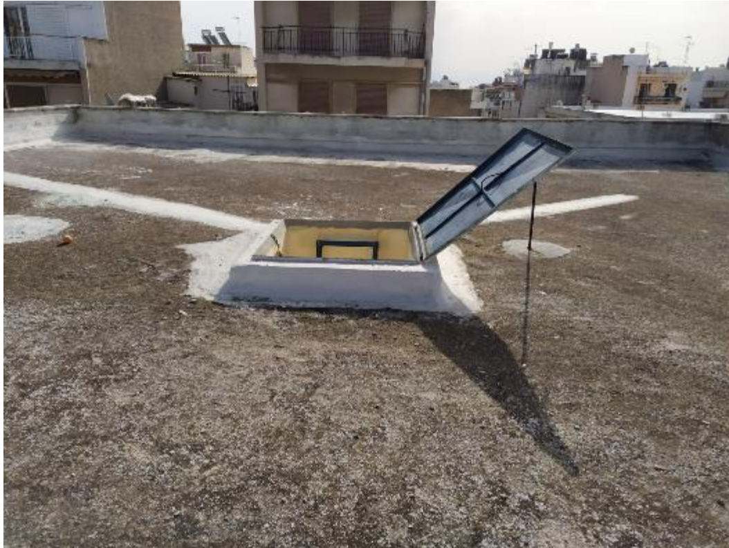
ΕΠΙΦΑΝΕΙΑ ΔΩΜΑΤΟΣ (εργασίες υγρομόνωσης)
