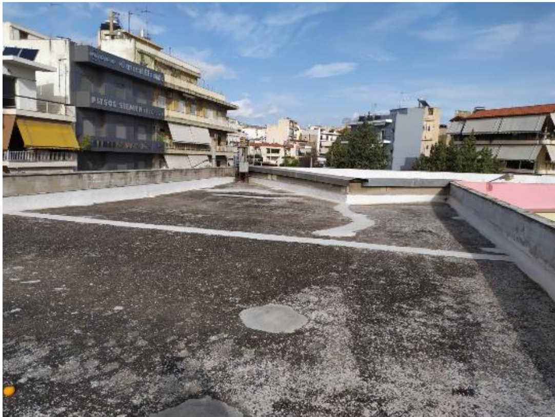
ΕΠΙΦΑΝΕΙΑ ΔΩΜΑΤΟΣ (εργασίες υγρομόνωσης)
