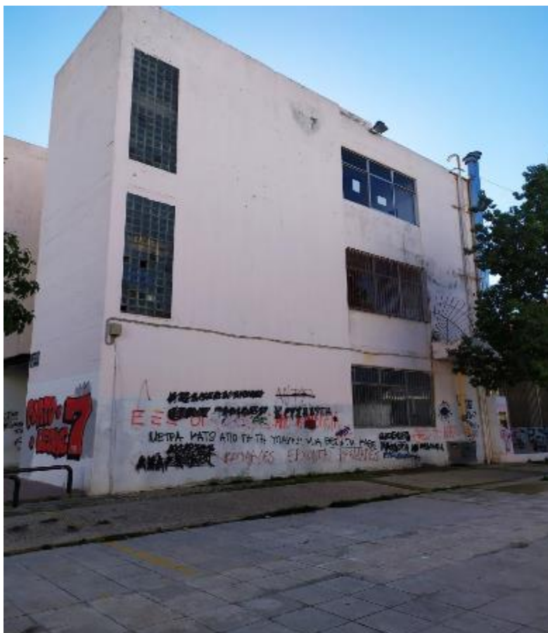
Αντικατάσταση των κουφωμάτων
